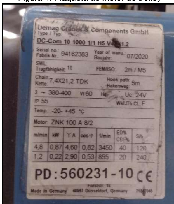
Figura 4: Plaqueta do motor do trolley
