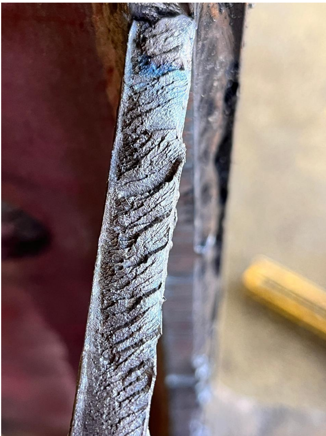
Propagação das fissuras – característica de fadiga
