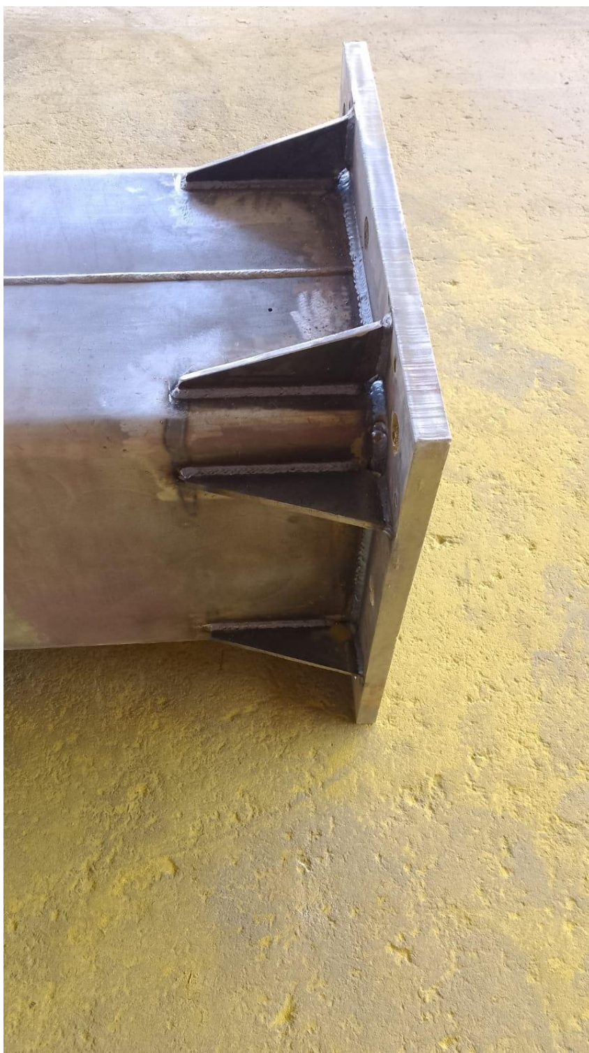
Cantoneiras adicionadas na base da coluna
