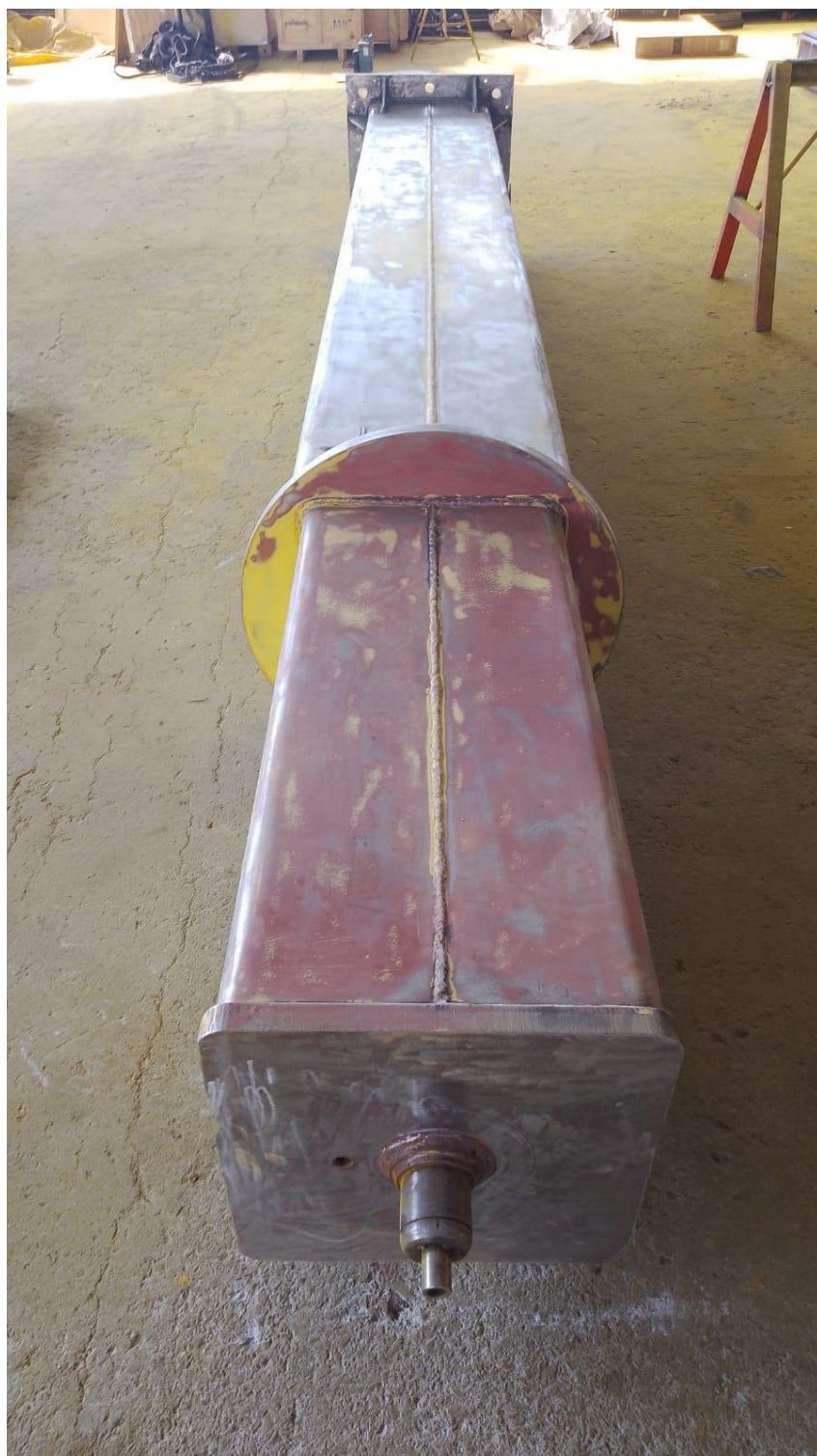
Coluna lixada para processo de pintura
