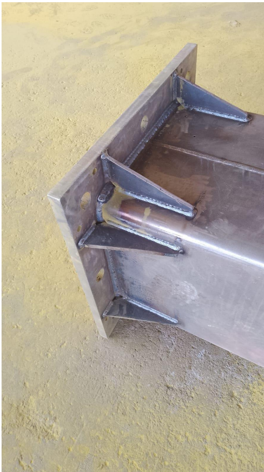
Coluna já cortada e soldada na base
