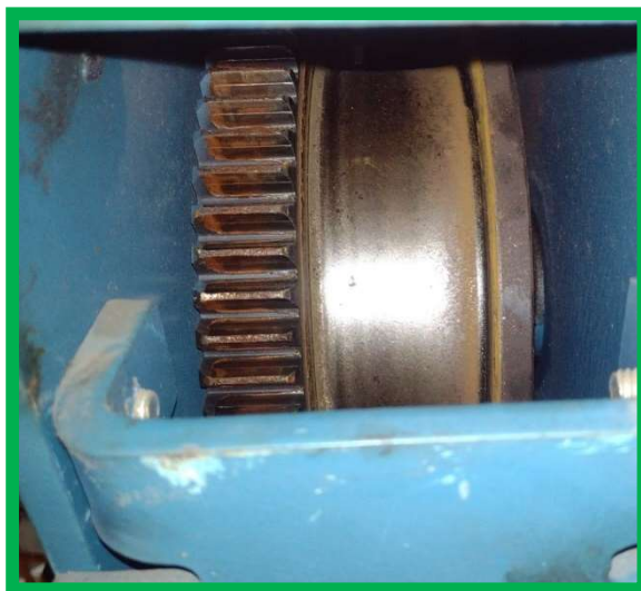
Roda tracionada de direção – Ponte Rolante 02
