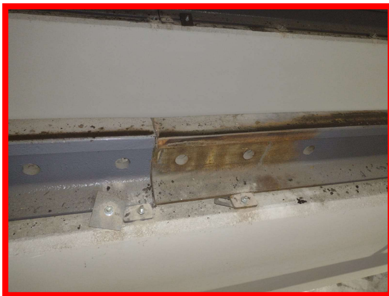
Trilho de rolamento sem tela de junção – Ponte Rolante 01
