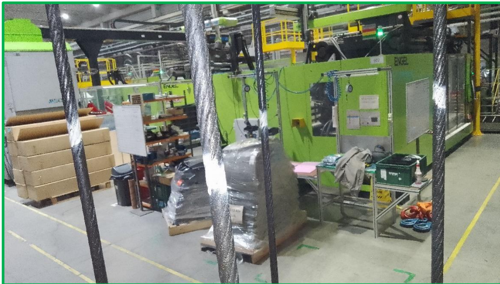
Cabo de aço – Posição 8 (-2,84%) - Ponte Rolante 23 TON.
