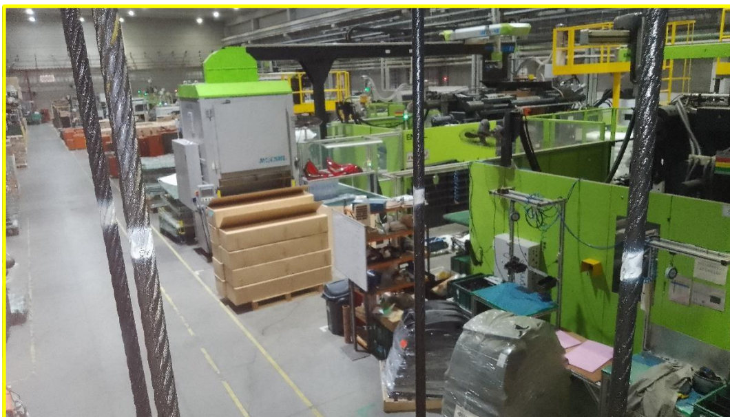
Cabo de aço – Posição 7 (-6,31%) - Ponte Rolante 23 TON.
