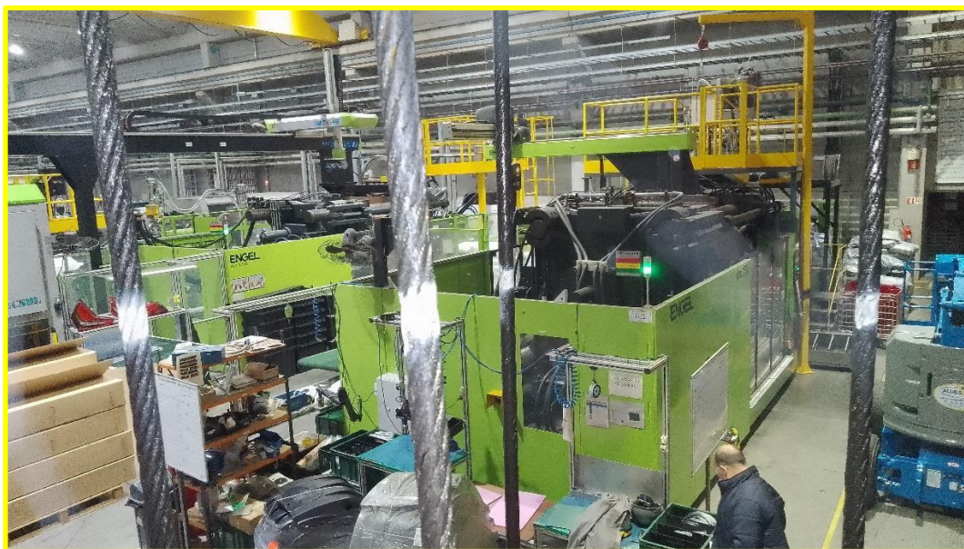
Cabo de aço – Posição 6 (-5,42%) - Ponte Rolante 23 TON.
