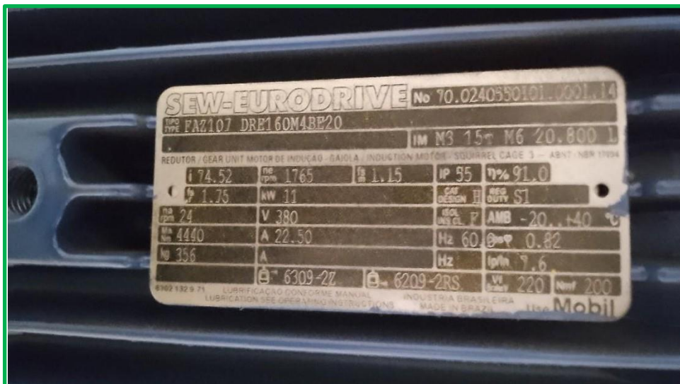
Placa de Identificação – Motor do tambor de elevação - Ponte Rolante 10 TON.
