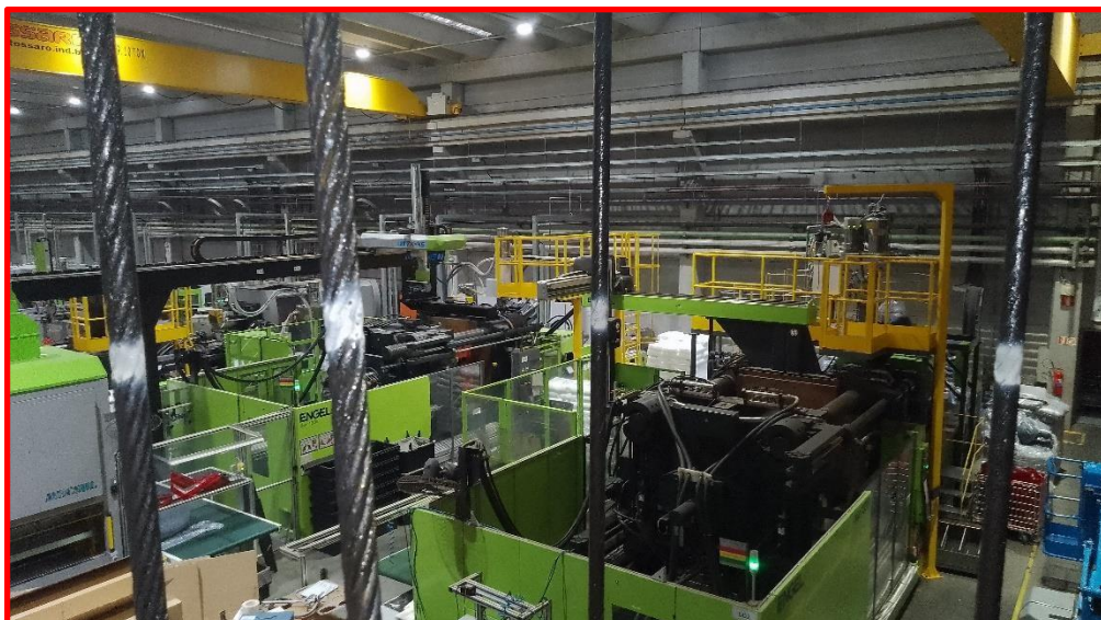
Cabo de aço – posição 4 (-7,42%) - Ponte Rolante 23 TON.
