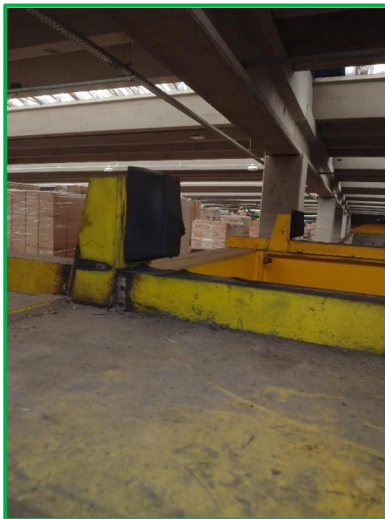
Batentes de Fim de Curso – Carro Troller – Ponte Rolante 23 TON.
