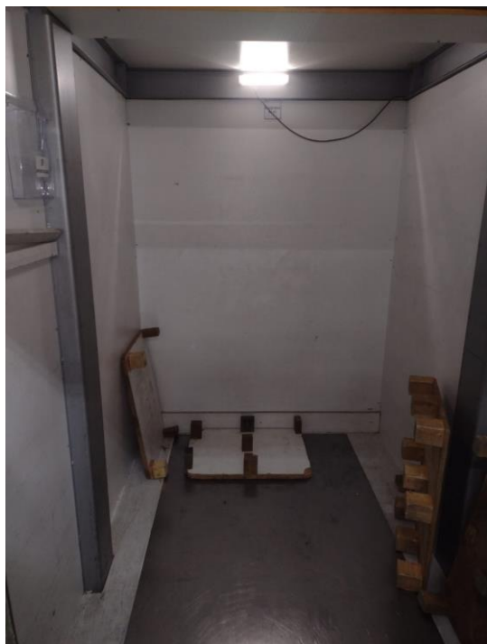
Cabine interna do elevador em boas condições
