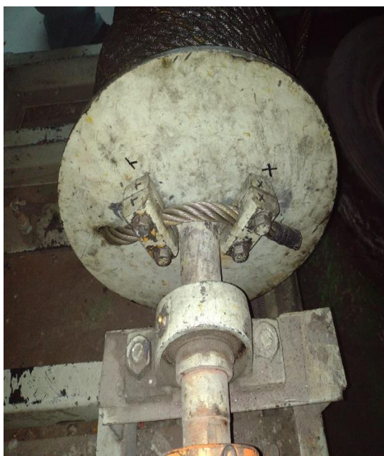
Fixação do cabo de aço no tambor correta
