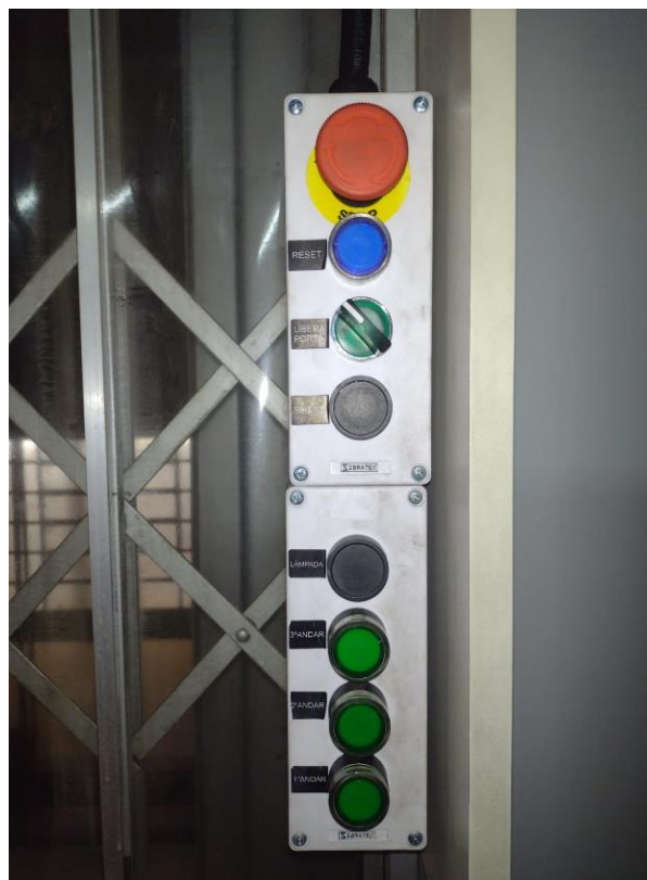
Quadros de comando 2º e 3º andar – Botão de emergência sem retenção
