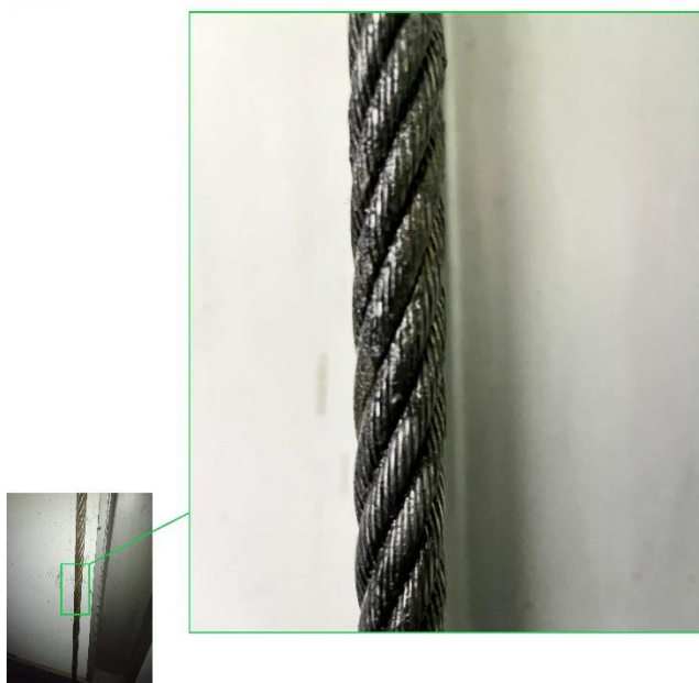
Cabo de aço em boas condições
