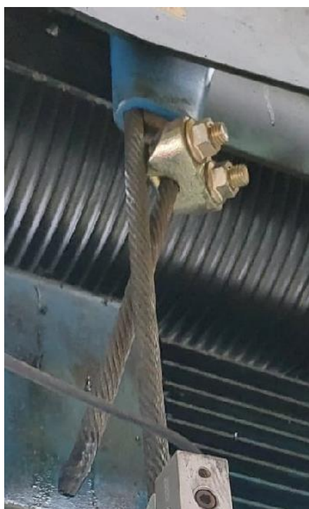
PONTO FIXO MONTADO CORRETAMENTE
