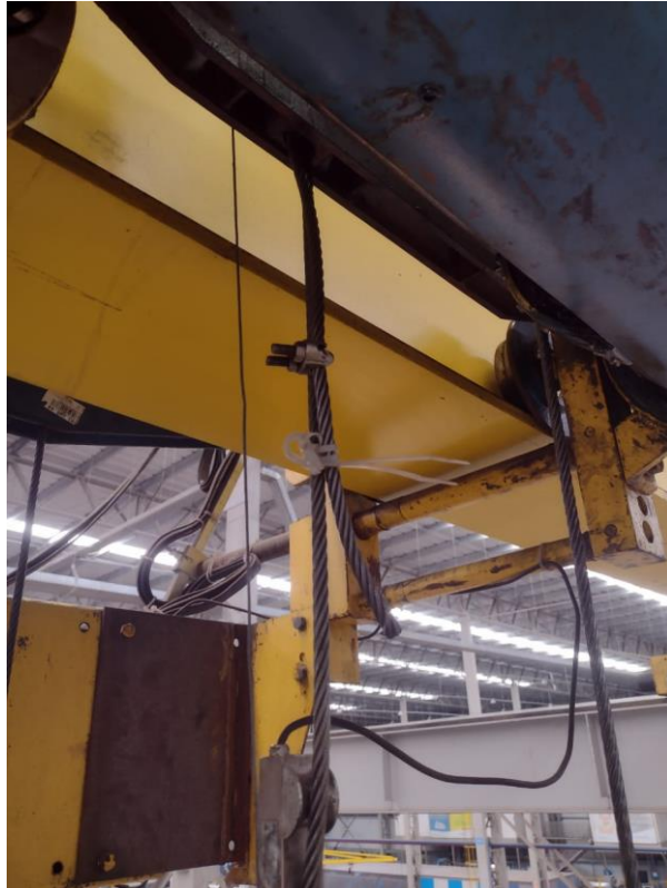
PONTO FIXO MONTADO CORRETAMENTE
