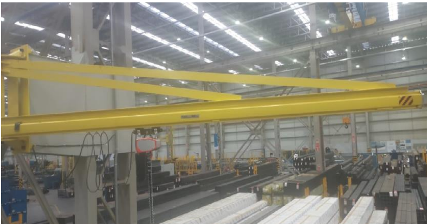
TALHA T07 COLUNA PAVILHÃO
