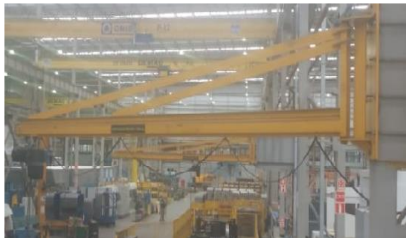
TALHA T05 COLUNA PAVILHÃO
